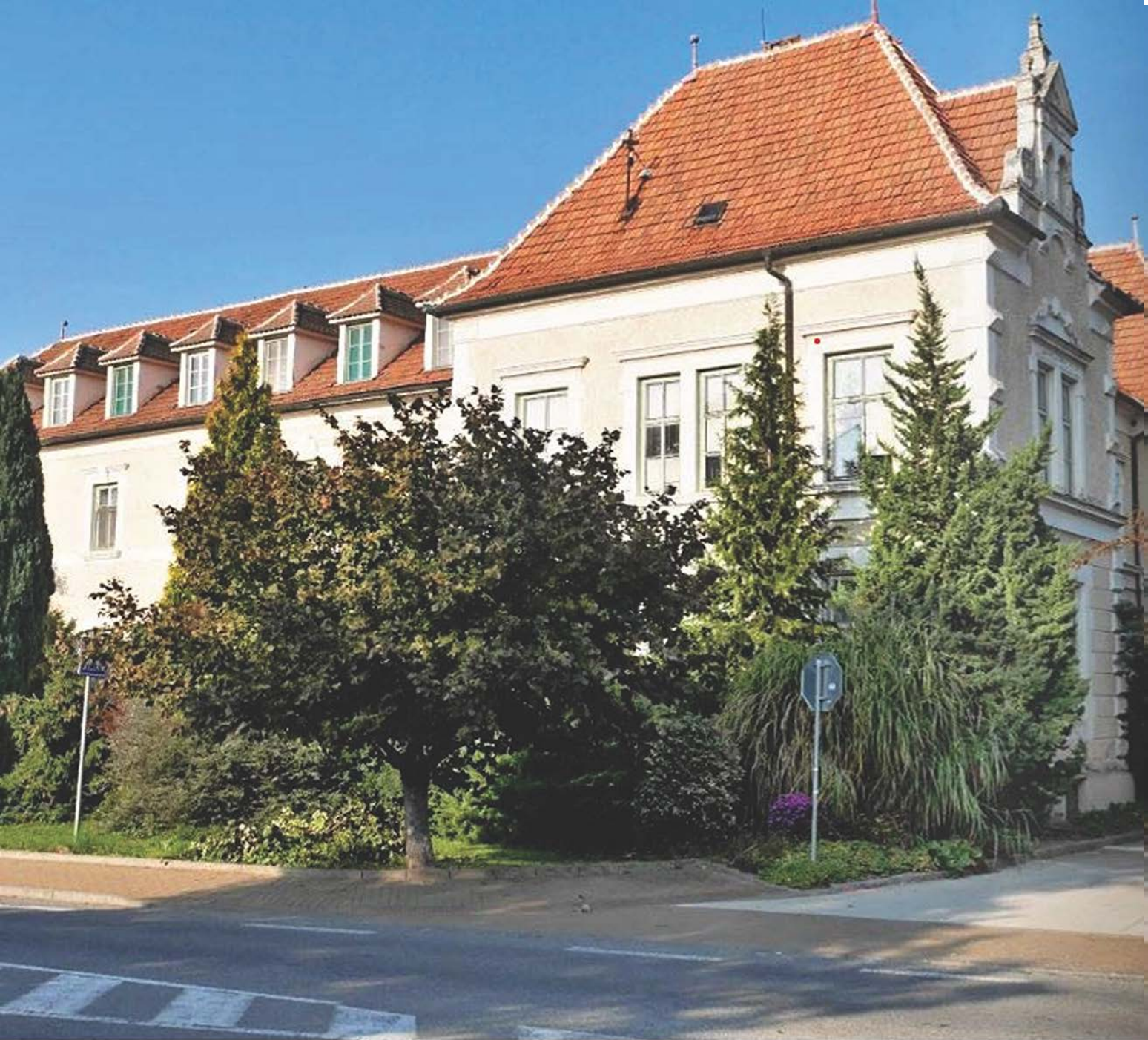
2] Pohled na průčelí budovy před rekonstrukcí
